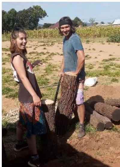
Mila a Ondra při stavbě hřiště
